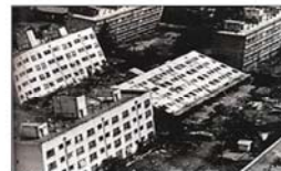
地盤支持力の消失によるアパートの転倒
