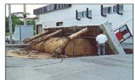
浮力による地下オイルタンクの浮上り
