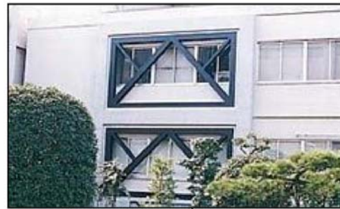
K型外部鉄骨ブレース工法
