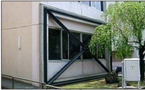
X型外部鉄骨ブレース工法
