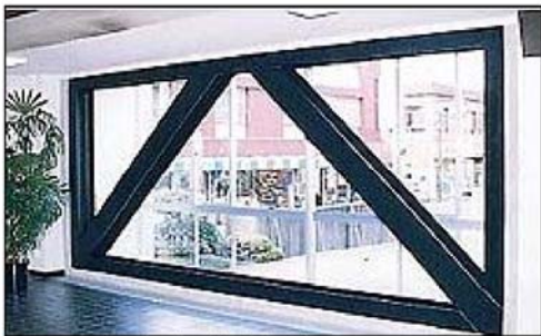
K型内部鉄骨ブレース工法
