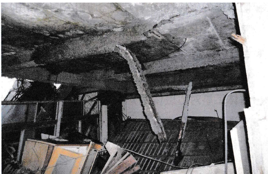
解体直前の居室部天井部分（野洲市）
